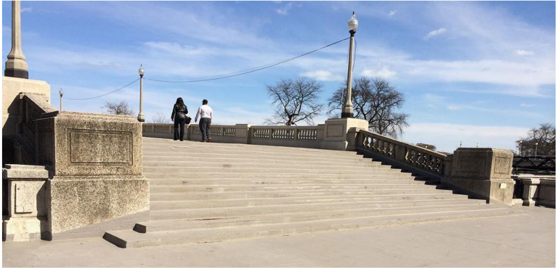
VAN BUREN PEDESTRIAN BRIDGE ADA RAMP
